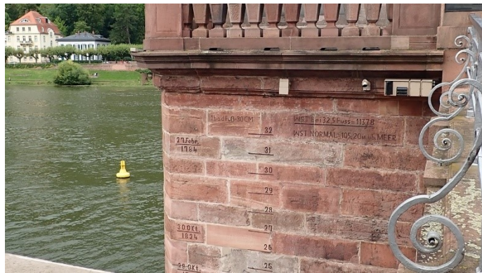
Abbildung 30: Hochwassermarken an der historischen Neckarbrücke in Heidelberg. Quelle: P. Krahe, BfG
