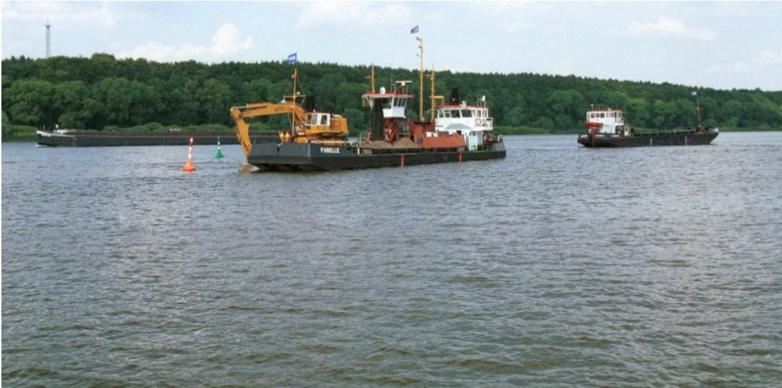
Abbildung 5: Baggermaßnahme im Rahmen einer Geschiebeumlagerung an der Elbe im Bereich des WSA Lauenburg
