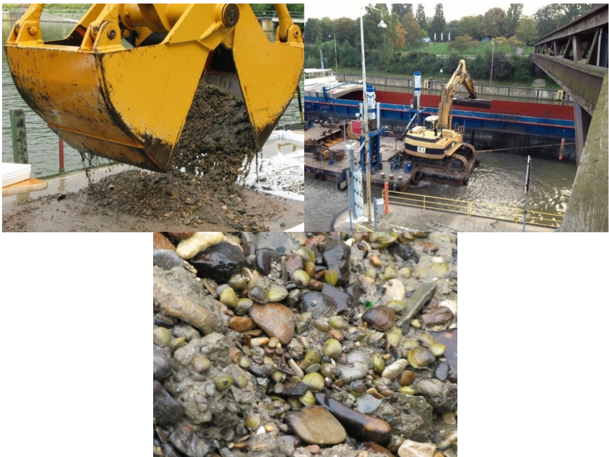
Abbildung 9: Nassbaggerarbeiten entlang des Neckars und anzutreffendes Baggergut
