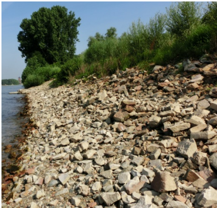
Bild 17: Zustand nach langem Überstau (15.7.2013)
