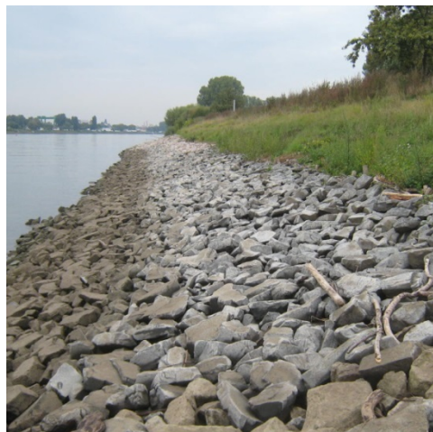
Bild 14: Zustand nach Sanierung (7.10.2013)
