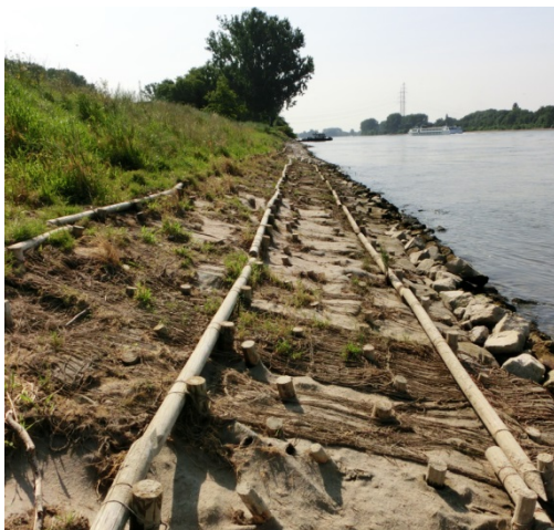
Bild 13: Zustand nach 10-wöchigem Dauereinstau (15.7.2013)
