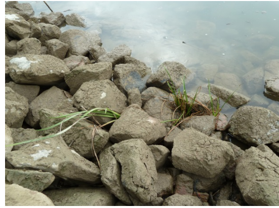
Bild 20: Wasserbausteine mit Schlammablagung im wellenschlaggeschützten Bereich; Ansiedlung erster Röhrlichtarten (26.8.2013)
