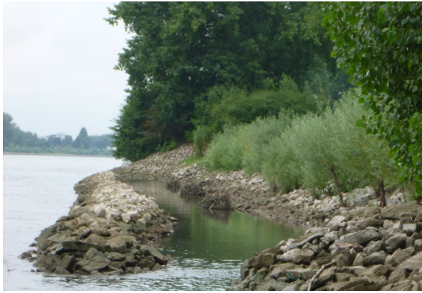
Bild 19: Blick auf die vor Wellenschlag geschützte Uferzone mit Weidensetzstangen (26.8.2013)
