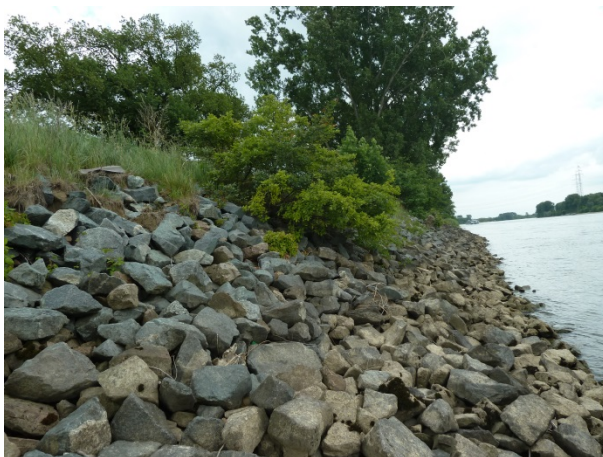
Bild 23: Maßnahmenbereich unterscheidet sich nur noch geringfügig von Referenzstrecke (Mai 2014)
