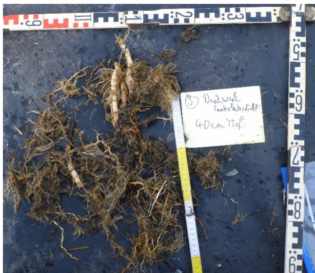
Abbildung 3-6: Schurf 3, Zschampert-Damm. Deckwerk an der Grenze zur Sauberkeitsschicht in 40 cm Profiltiefe.
