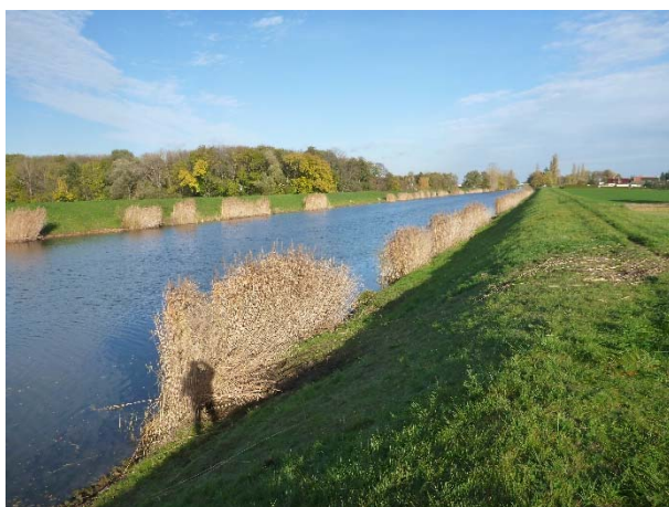
Schilf am Saale-Leipzig-Kanal und Durchwurzelung der Tondichtung, Schurf 1, 04./09.11.2020
