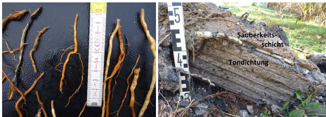
Abbildung 3-11: Links: Wurzeln und davon abgehende einzelne Feinstwurzeln aus der Tondichtung in Schurf 2. Rechts: Rhizom mit Verlauf auf der Dichtungsoberkante in 60 cm Profiltiefe von Schurf 3.
