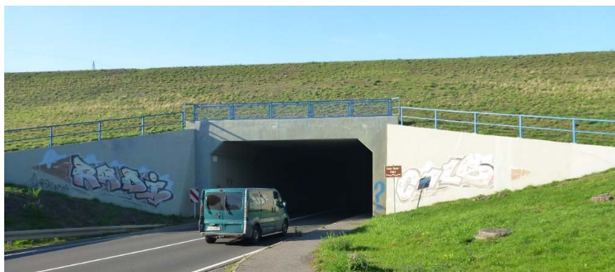
Abbildung 2-2: Untertunnelung der hohen Dammstrecke des Dölziger-Damm.
