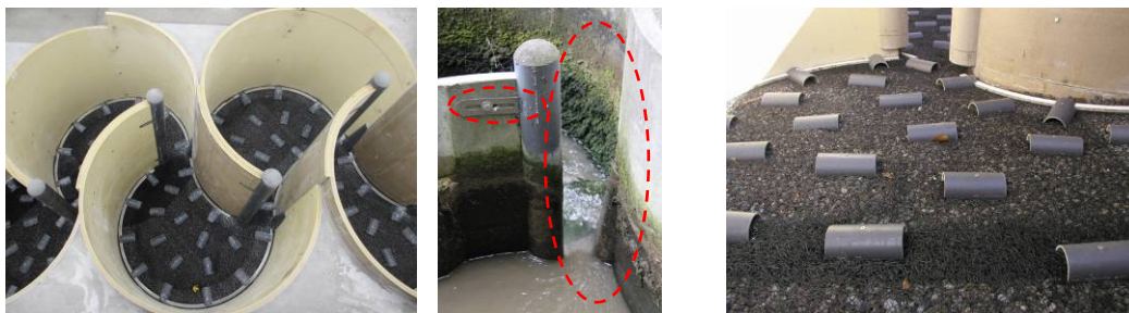
Abb. 1: Links: Anordnung von GfK-Halbrohren bei einem C-Typ, mittig: „Umlenkrohre“ zur Schlitzweitenregulierung, rechts: Sohlauflauf (Peters Ökofisch GmbH & Co. KG, IWD); (Fotos: Peters Ökofisch GmbH & Co. KG)
