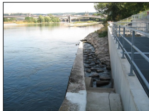
Abb. 4: Typ „C“ – abgerückter Einstieg mit Sohlanbindung
