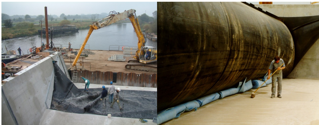
Abb. 2: Montage einer Schlauchmembran beim Wehr Marklendorf/Aller (links) und Reinigung des Ablagetisches beim Wehr Kiebingen/Neckar (rechts) (Fotos: BAW)
